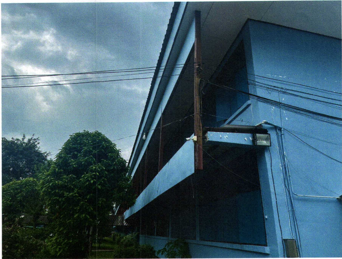
ภาพถ่ายด้านหลังอาคาร
